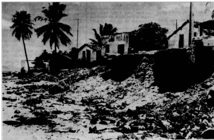
Figura 5 - Destruição causada pelo mar na antiga Rua da Praia em Rio do Fogo
